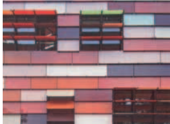
Da die hier eingesetzten farbigen Gläser halbdurchsichtig, kleinflächig und reflexionsarm sind, können Vögel sie gut erkennen.
