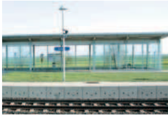
Allseitig verglaster Warteraum
