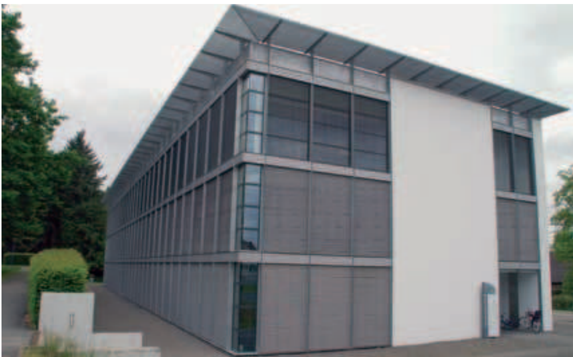
So ist es richtig: Die Jalousien sind an Wochenenden und nach Arbeitsschluss geschlossen.
