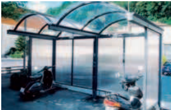
Zweiradunterstand mit halbtransparenten Seitenwänden. Das gewölbte, durchsichtige Dach dürfte problemlos sein.
