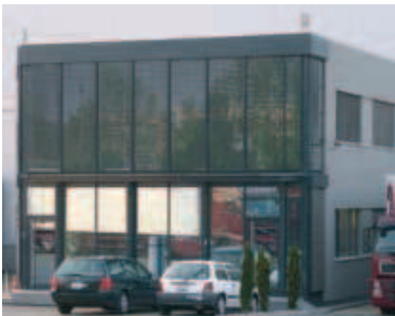
Sonnenschutzglas bei einem Firmeneingang. Durch die Sonnenstoren wird im Obergeschoss die Spiegelung markant gebrochen.
