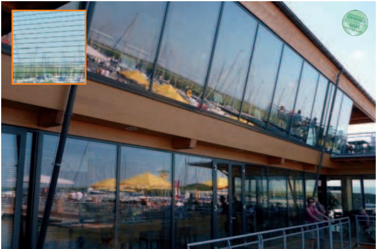
Die Scheiben des Seerestaurants beim Nationalpark Neusiedlersee wurden aussen konsequent mit dünnen schwarzen Linien bedruckt (siehe S. 17).
