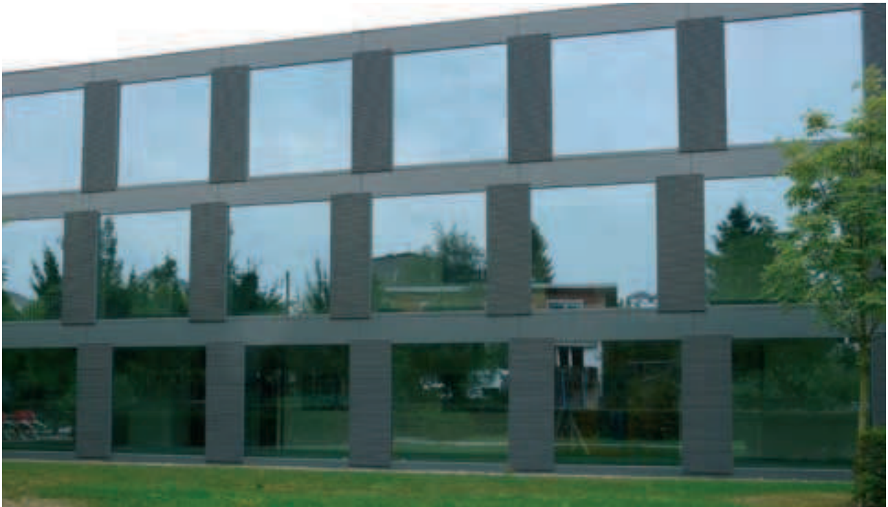
Grosse Fronten, starke Spiegelungen, mitten in gut begrünem Quartier – das sind Todesfallen, die sich im Nachhinein meist kaum mehr entschärfen lassen, allein schon aus finanziellen Gründen.
