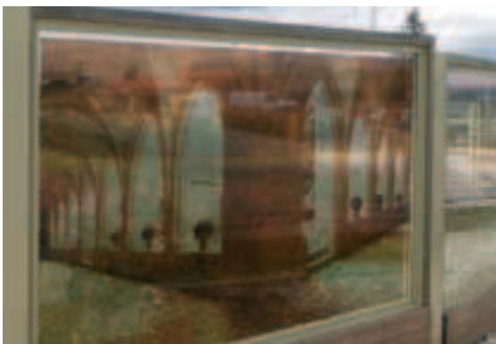
Historisches Motiv, als Film in Lärmschutzwand einlaminiert. Leider blieben die benachbarten Elemente transparent.
