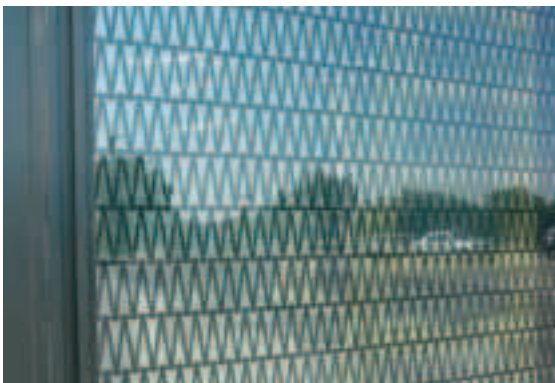
Dieser Siebdruck wurde im Inneren des Isolierglases aufgebracht, weshalb Spiegelungen sichtbar bleiben.
