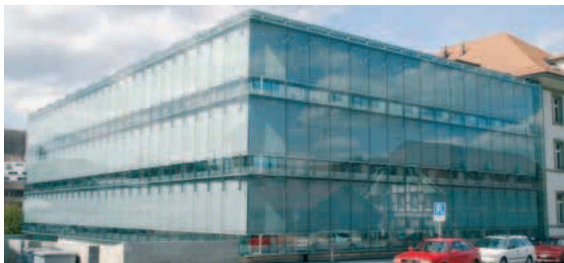
In Glasfassade integriertes Beschattungssystem. Die Spiegelung ist zwar nicht völlig reduziert und sie wird durch den Aufnahmewinkel sogar noch etwas verstärkt. Trotzdem hält sie sich dank des hellen Stoffes einigermaßen in Grenzen.
