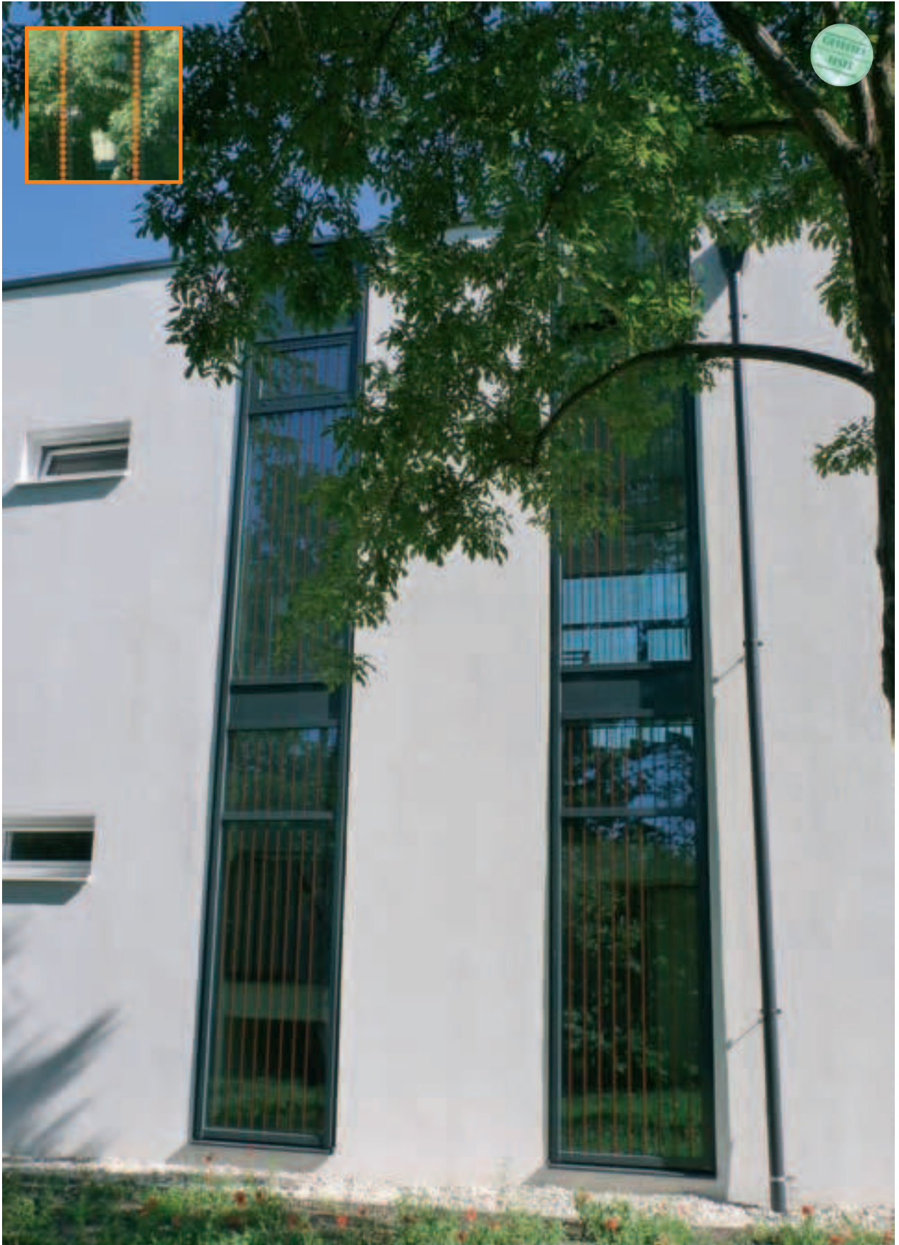
Einige der im Flugkanal als hoch wirksam getesteten Muster werden inzwischen schon werkseitig zum Aufdruck auf das Glas angeboten und müssen nicht erst nachträglich als Folienlösung appliziert werden.
