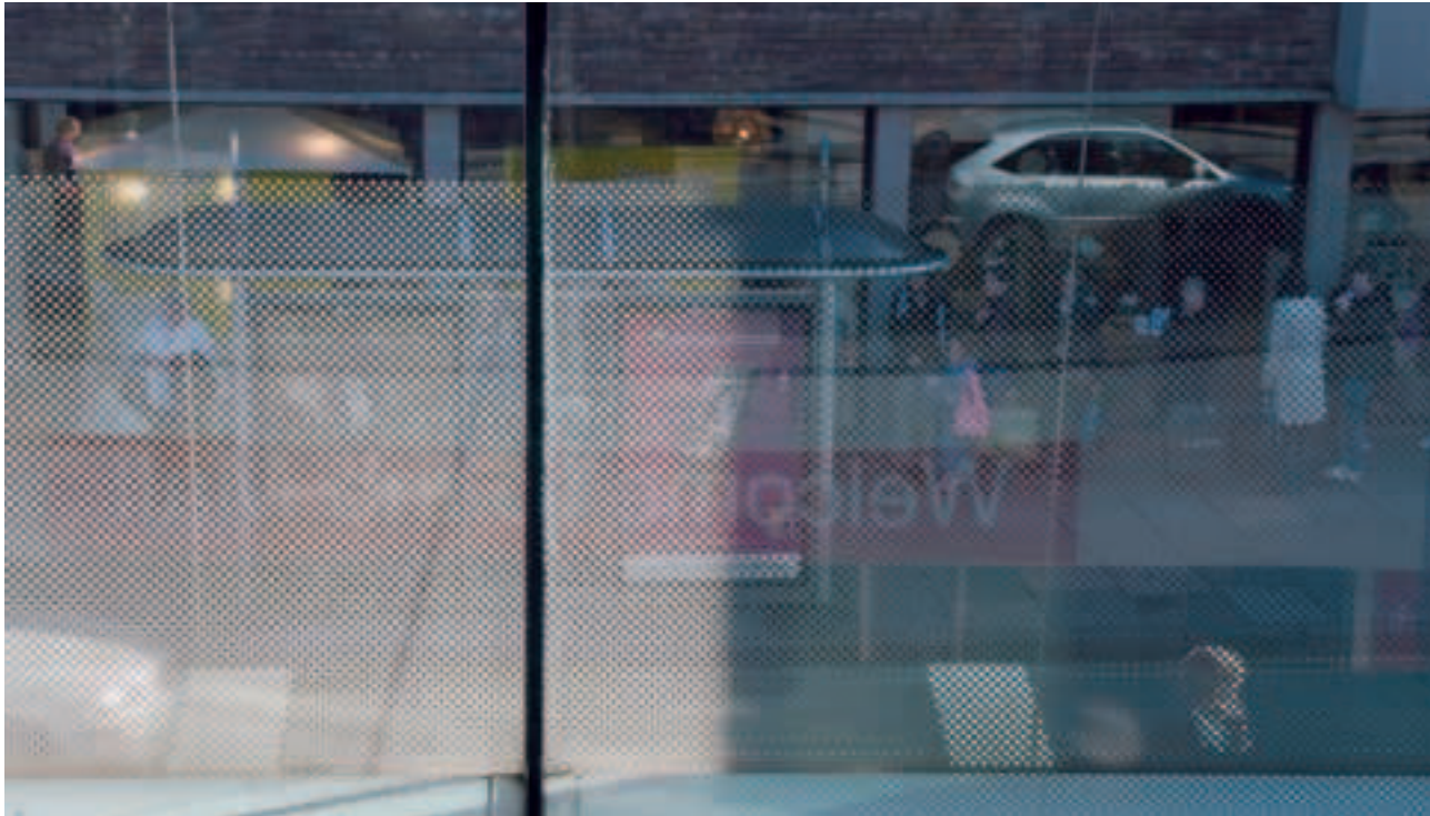
Je nach Beleuchtung wirken Markierungen auf Scheiben sehr unterschiedlich. Auf diesem Schaufenster ist durchgehend ein sehr dichter Punktraster aufgetragen. Während im nicht direkt von der Sonne beschienenen rechten Teil einiges zu erkennen ist, wirkt das Bild links viel diffuser. Für einen wirksamen Kollisionschutz ist im übrigen ein etwas lockereres Raster ausreichend.
