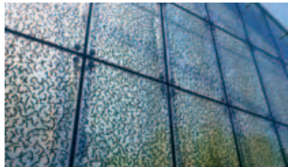
Dieses Dekor am Regenwaldhaus im Tiergarten Schönbrunn bewahrt auch die tropischen Vögel im Inneren vor Anflügen.
