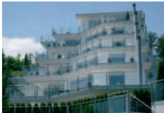
Bei dieser Wohnüberbauung bestehen sämtliche Balkonbrüstungen und Abschränkungen aus transparentem Glas.
