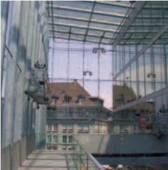
Verglaster, nachträglich angefügter Vorbau an einer Bahnhofshalle
