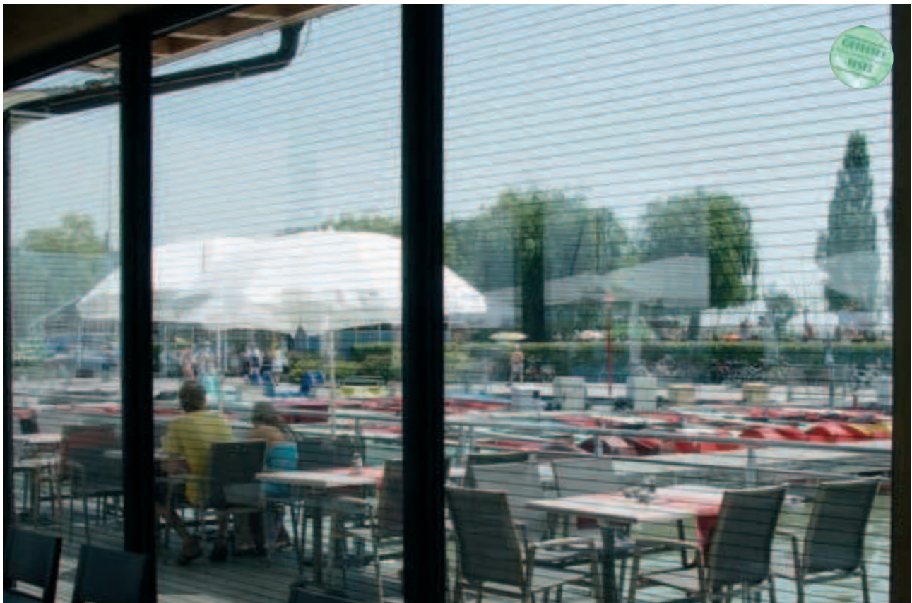
Der Blick vom Restaurant nach draussen wird durch die feinen Linien des Vogelschutzglases nicht beeinträchtigt. Durch das Muster ist gewährleistet, dass die Gäste vor toten Vögeln verschont bleiben.
