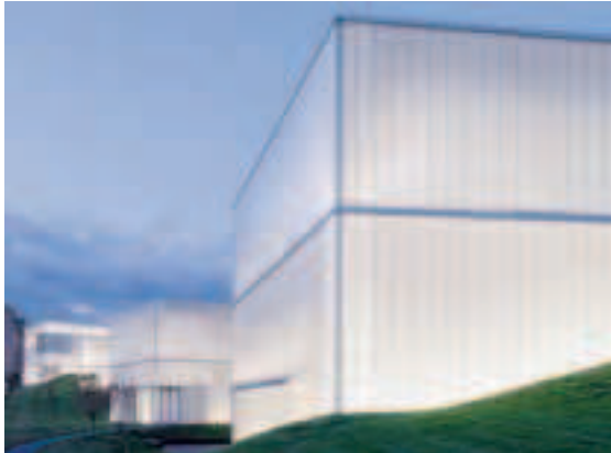
Lichtstreuende Isolierplatten in doppelschaligem U-Profilglas machen Tageslicht nutzbar und reduzieren Wärmeverluste erheblich. Sie sorgen für eine optimale gleichmäßige Lichtabgabe in den Raum.
