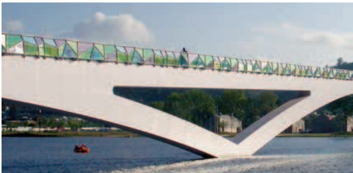
Diese Fussgängerbrücke in Coimbra/Portugal bringt Farbe in die Landschaft.
