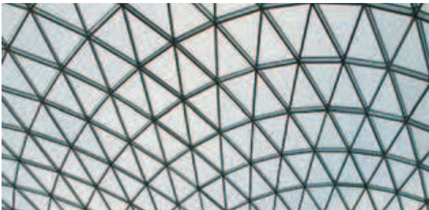
Diese Dreiecks-konstruktion ergibt eine noch verstärkte Netz-wirkung.
