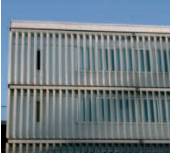
Lisenen («Schwerter») und vertikale oder horizontale Lamellen beschatten und gliedern die Fassade. Wenn so dicht wie in diesem Beispiel angebracht, besteht kaum mehr Gefahr.
