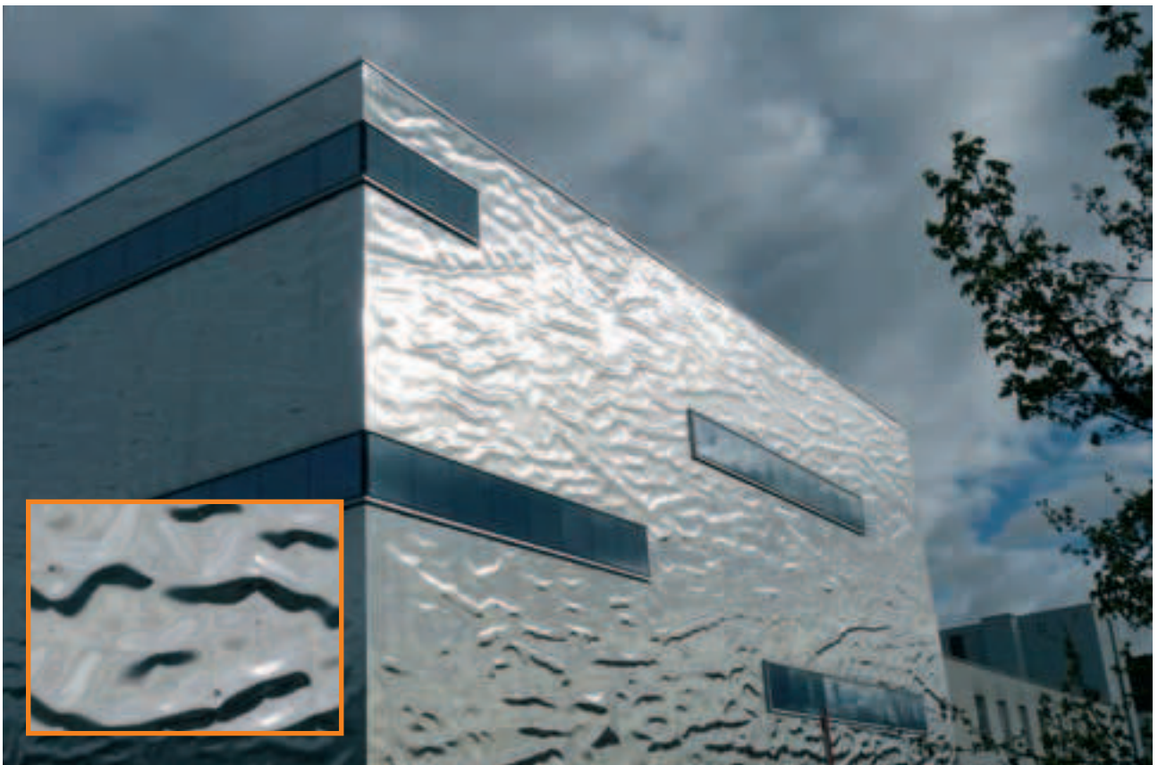
Dieses Lagergebäude ist zwar grossflächig mit einer stark spiegelnden Metallverkleidung ummantelt. Aufgrund der ausgeprägten Wölbungen dürfte es jedoch für Vögel unbedenklich sein.
