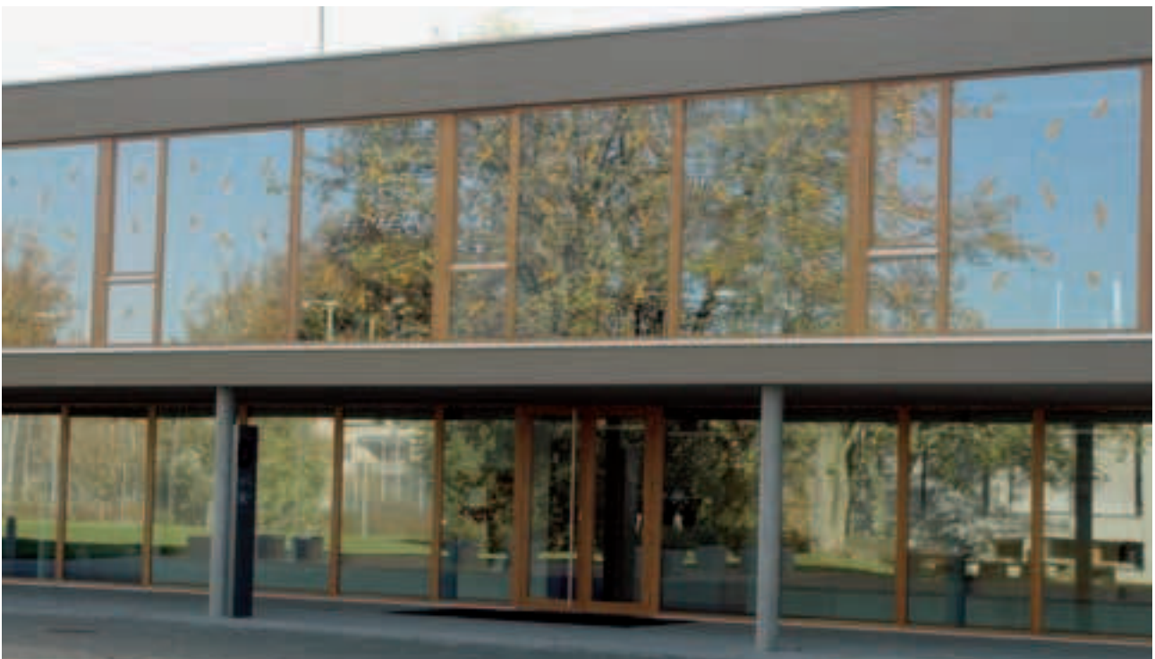
Ein Schulhaus-Neubau mit einer breiten, zweigeschossigen Glasfront. Wegen des eingesetzten Glases mit hohem Reflexionsgrad kam es dauernd zu Kollisionen. Die farbigen Silhouetten wurden von den Schülern und den Biologielehrern in einer «Verzweiflungstat» angebracht. Die Kollisionsgefahr wurde damit etwas gemildert, doch das Problem ist weder ästhetisch befriedigend noch wirkungsvoll behoben.
