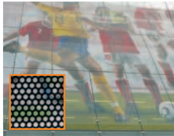
Mit Folien lassen sich ganze Fassaden werbewirksam einkleiden. Sie sind meist perforiert und gewähren damit eine gewisse Durchsicht.
