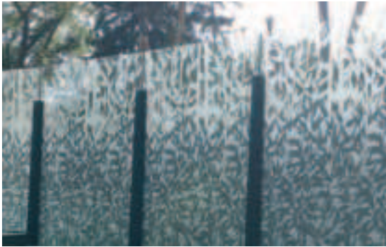
Lärmschutzwand: ist wirksam, trotz pflanzenartigem Design.
