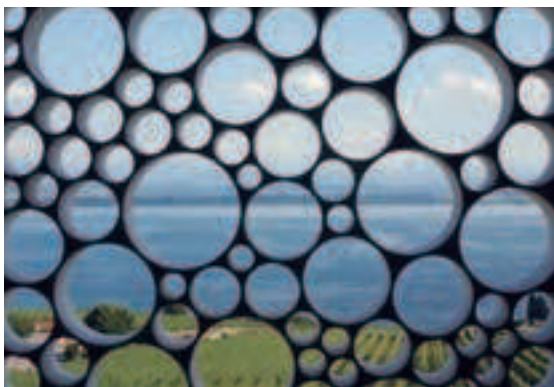
Spielerische Inszenierung von Aussicht – und zugleich ein wirkungsvoller Vogelschutz (vorgespannt vor Glasfront).
